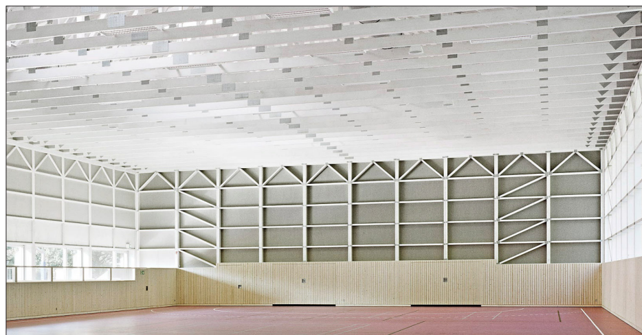
Die Sporthalle wurde ausgezeichnet als „gelungenes Beispiel, wie sich auch unter strengster Kostendisziplin qualitativ hochwertige Architektur schaffen lässt“. Die Konstruktion aus weiß eingefärbten Nagelplattenbindern hat Laumer Bautechnik in Massing gefertigt. – Foto: Sebastian Schels
